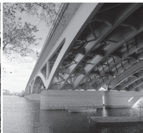
▲アーチ桁下部（道の駅しょうなん側より） 撮影：平成30年11月
