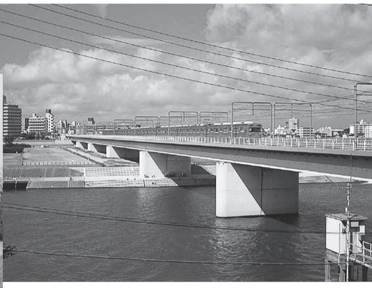
▲工事完成後（東京方から川崎方を臨む） 構造は連続箱型鋼橋梁（約63m×6径間、桁高3m）
